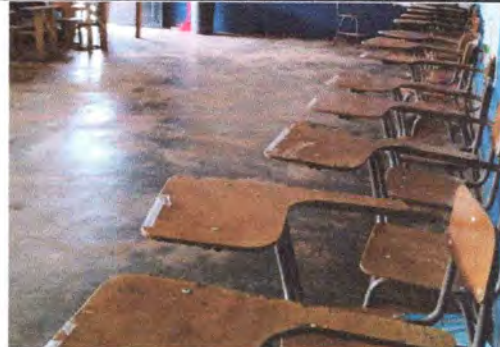
Foto 2: La sustitución del piso liso se realizara debido al deterioro que a sufrido por el paso de los años.
