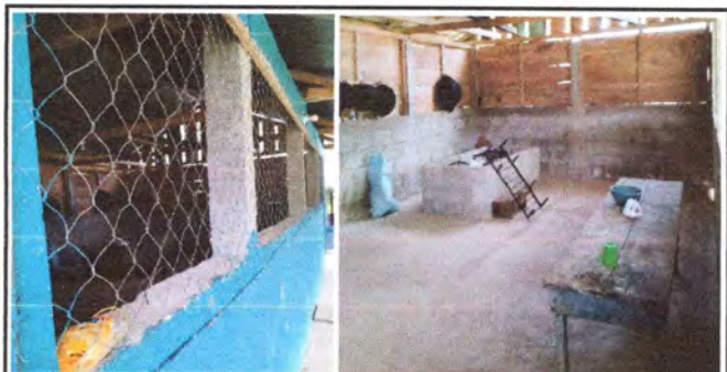
Foto 6: Sustitución de ventanas de madera y malla por balcones de metal para cacina del establecimiento.
