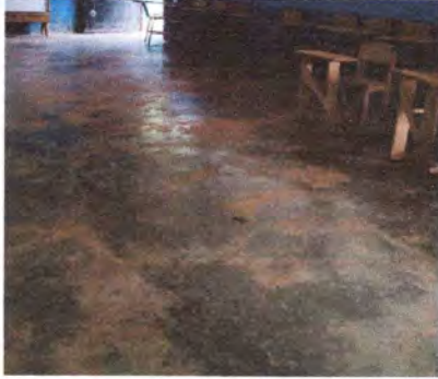
Foto 1: Sustitución e instalación de piso liso por piso ceramico
